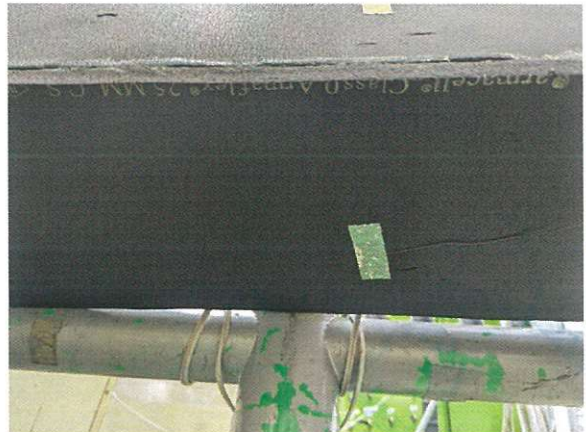
風管試驗完畢後外壁相片(第 30 分鐘)
