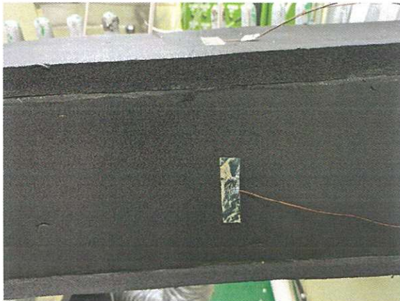
風管試驗完畢後外壁相片(第 30 分鐘)
